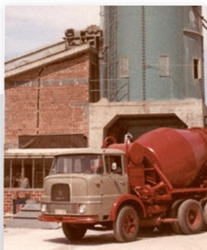
Das erste Transportbetonwerk der Kies und Beton AG, Baden-Baden, 1960
